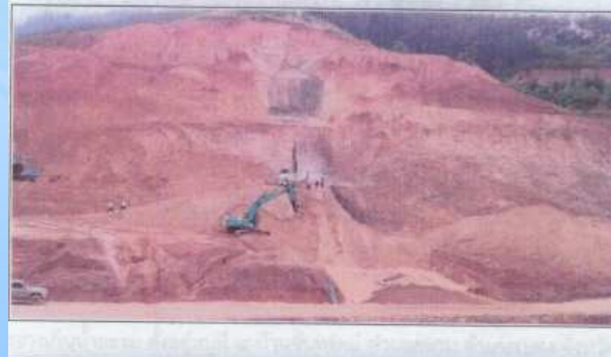
ภาพการก่อสร้างอ่างเก็บน้ำยะรม
